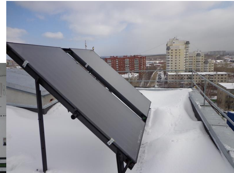
Установка солнечных коллекторов на кровле здания лаборатории
