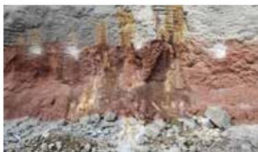
Иллюстрация 2. Протечки через торкрет-бетонный бортовой экран карьерной выемки. Фото С. В. Кузнецова. 2018 г.
